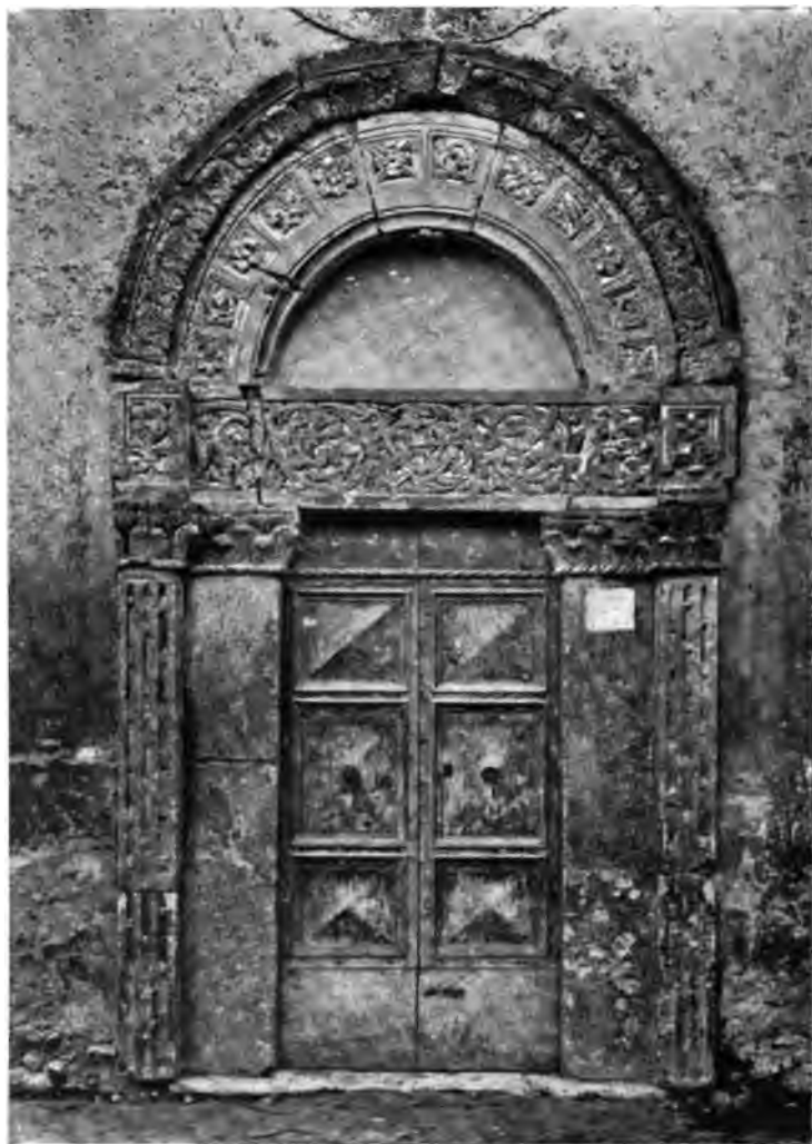
AVEZZANO — CHIESA DI S. NICOLA — PORTA CENTRALE.
